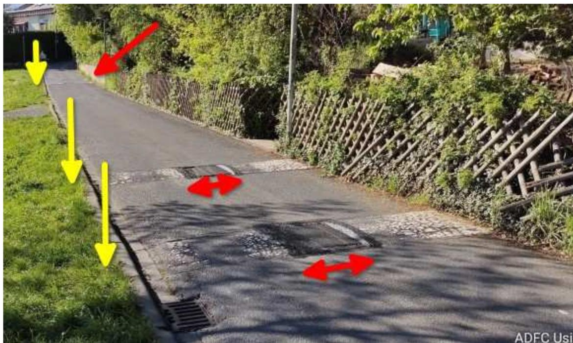
Bild 01 | gelbe Pfeile: Pfosten, rote Doppelpfeile: Durchlässe, roter Pfeil: 2. Schwellenblock
